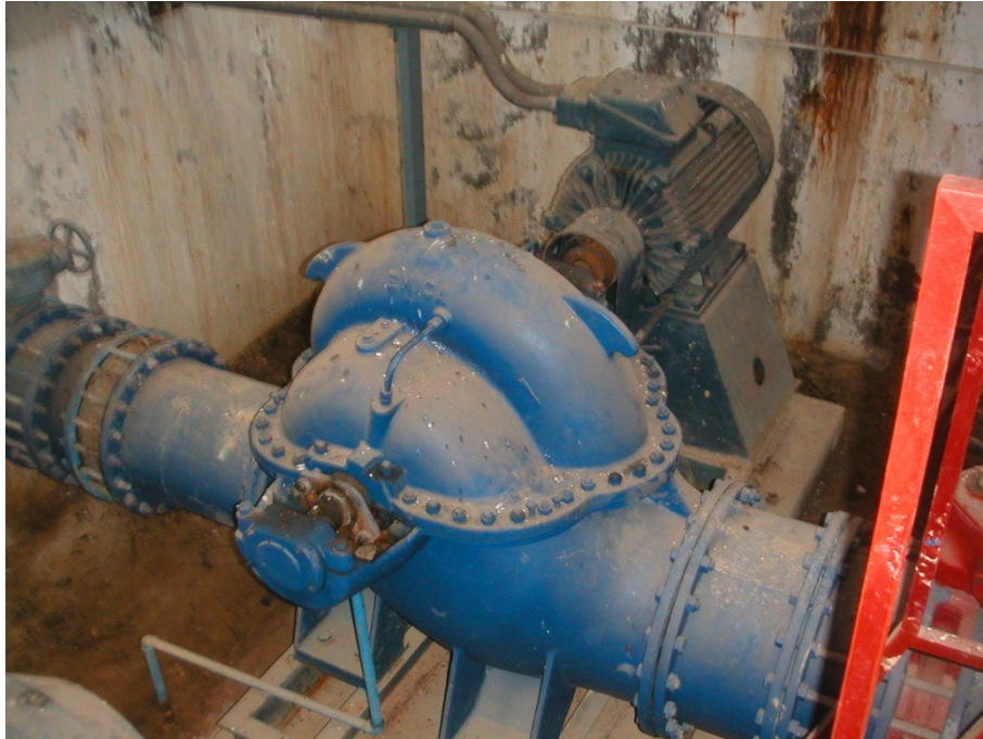
Foto 11. Bombament amb un manteniment deficient.
