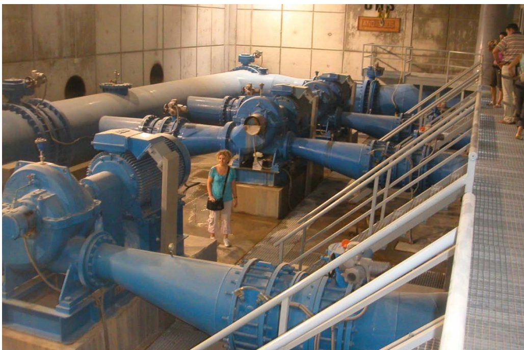
Foto 8. Estació de bombament amb grans equips a la Comunitat de Regants de Lorca.
