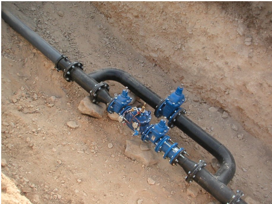
Foto 2. Vàlvula reductora de pressió instal·lada en una canonada de distribució.
