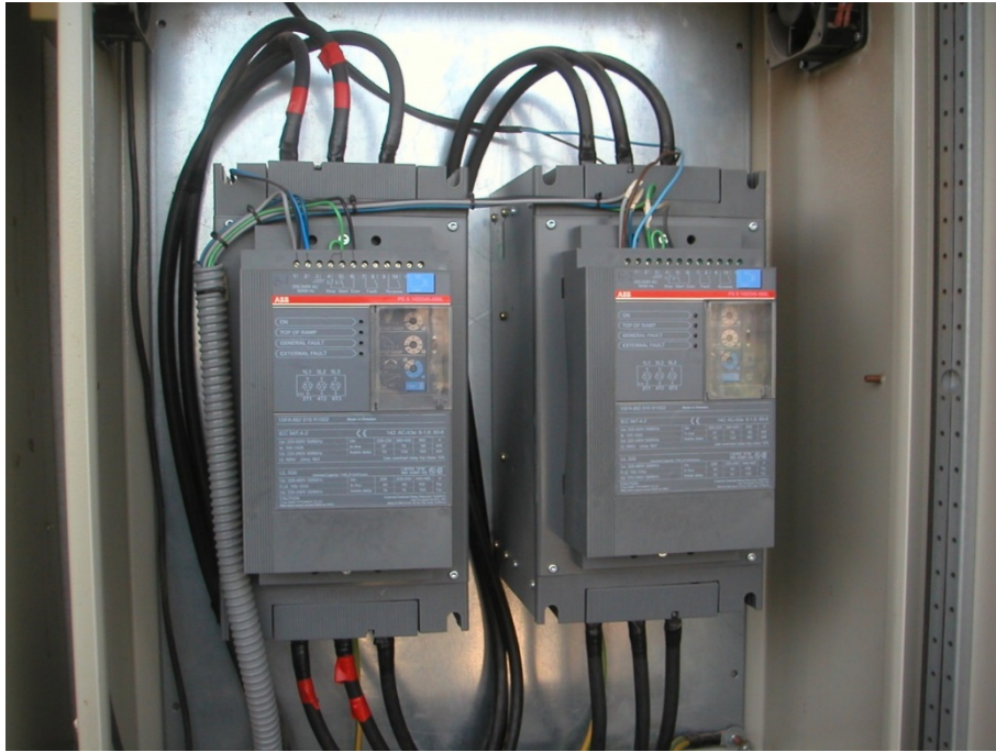
Foto 10. Engegadors Electrònics.
