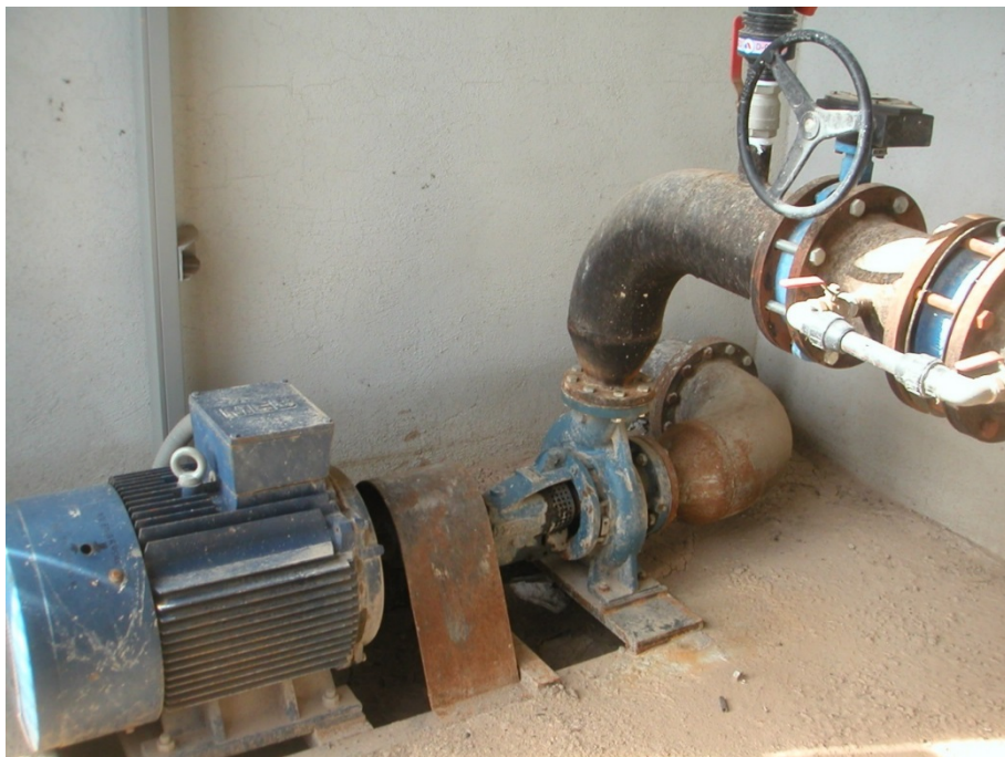
Foto 5. By pass a la vàlvula de retenció d'una impulsió.
