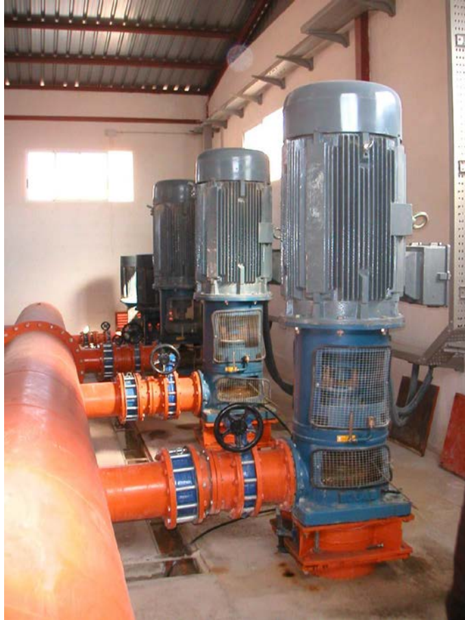
Foto 9. Estació de bombament amb grups de diferent mida a la Comunitat de Regants d'Albatera.
