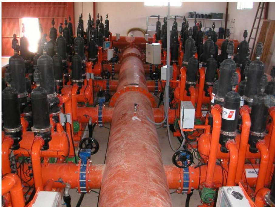
Foto 3. Sonda de pressió en col·lector d'impulsió de l'estació de bombament i filtrat de la Comunitat de Regants d'Albater
