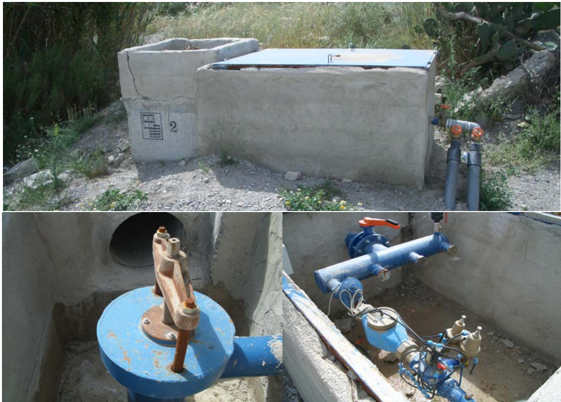
Foto 7. Hidrant col·lectiu per a reg a pressió i per gravetat a la mateixa arqueta.
