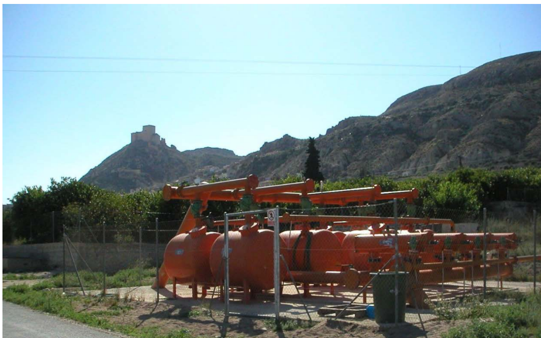
Foto 6. Estació de filtrat en un sector de reg de la Comunitat de Regants de Mula.
