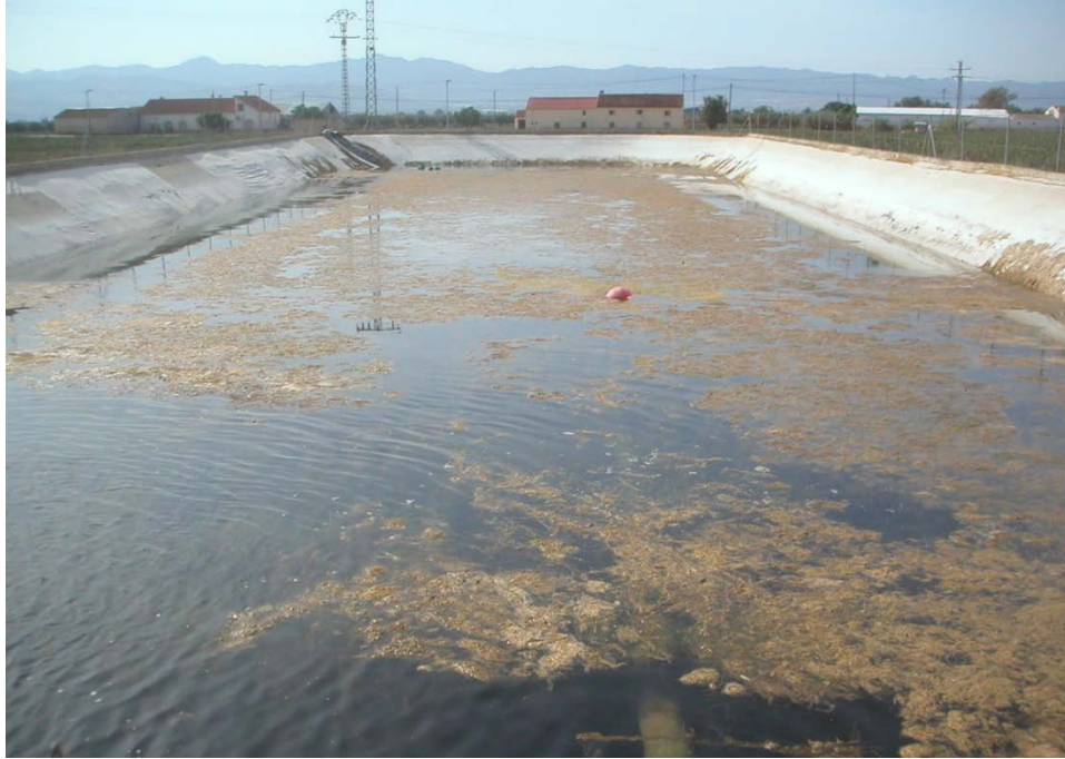
Foto 4. Bassa d'aspiració d'un bombament amb algues i oves en suspensió.
